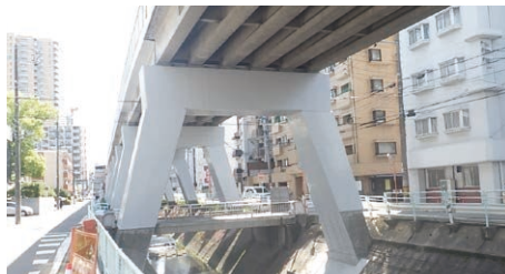
耐震補強を施した橋脚
