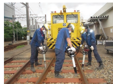
軌道保守（砕石道床つき固め作業）
