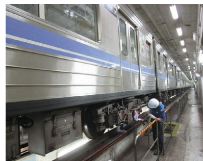
電車車庫での整備
